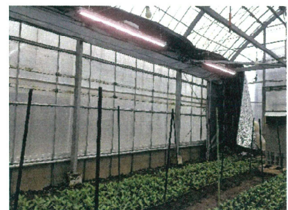
写真2 LED照明設置状況
