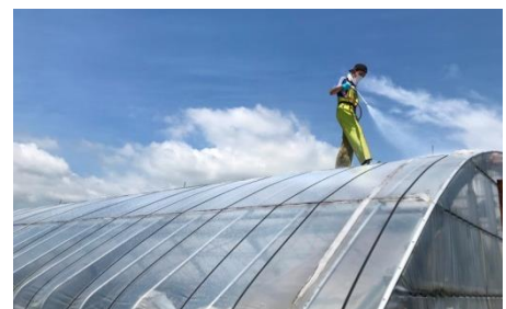
写真1 遮光塗布剤の処理
